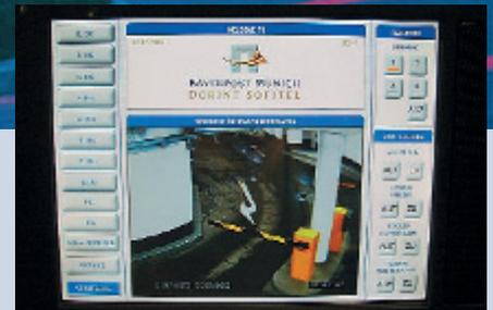
Eines der Crestron-Touchpanels zur Steuerung von Licht, Video, Audio und Gebäudefunktionen. Das Videofenster zeigt eine der Überwachungskameras.
